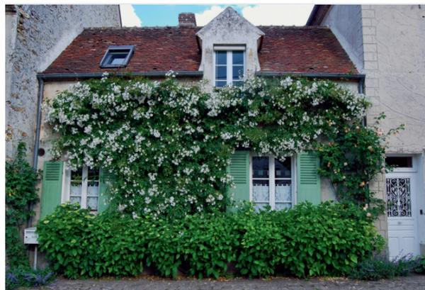
Les ouvertures : simples encadrements, corniches, bandeaux d'angles ou d'étage, soubassement d'enduit soulignent la composition tout en éloignant l'eau de pluie du parement.
